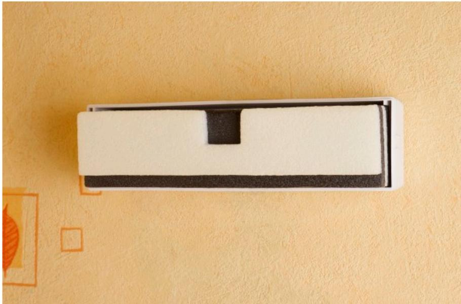
6. Клапан закрывается крышкой с заслонкой для регулирования подачи воздуха.
