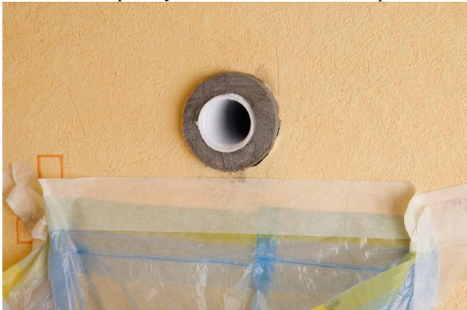
4. Делается разметка под крепления корпуса, просверливаются отверстия  $\varnothing$  6 мм, вставляются дюбели. Корпус клапана крепится на 4 самореза.
