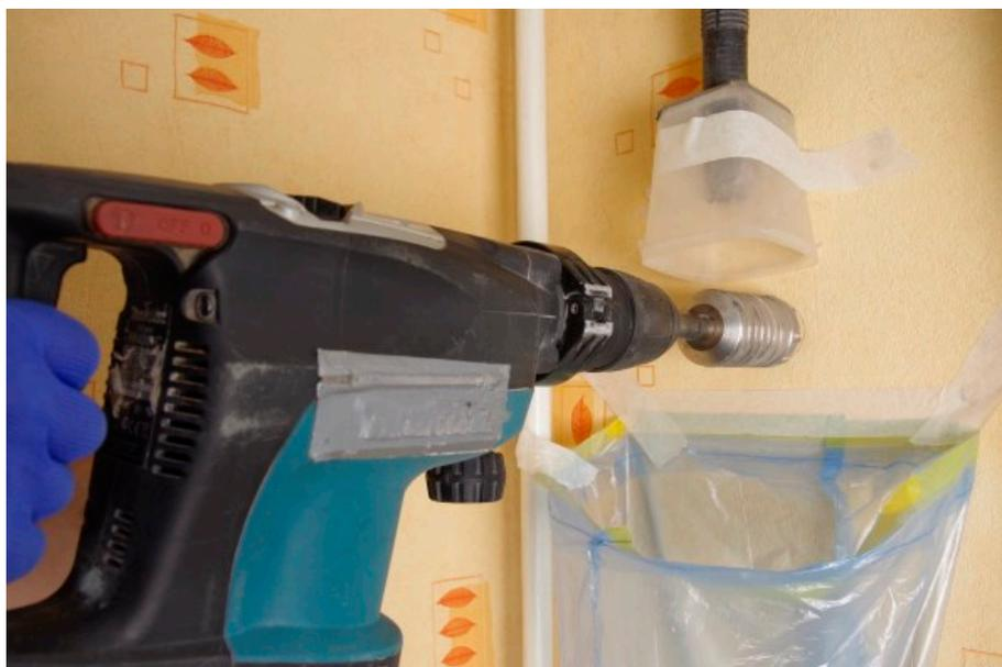
2. Делается сквозное отверстие  $\varnothing$  4 см под небольшим углом вниз.
