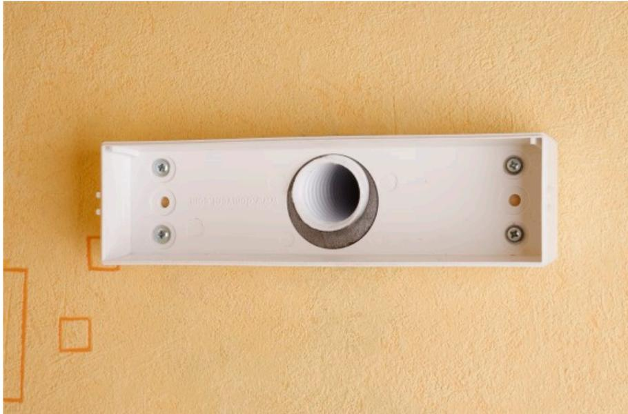
5. В корпус клапана вставляется глушитель с встроенным фильтром класса G3.
