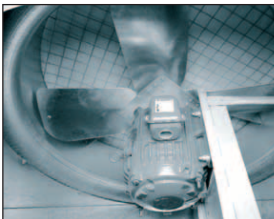
Система прямого привода вентилятора
