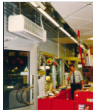
Свободная подвеска с потолка на гибких тягах
