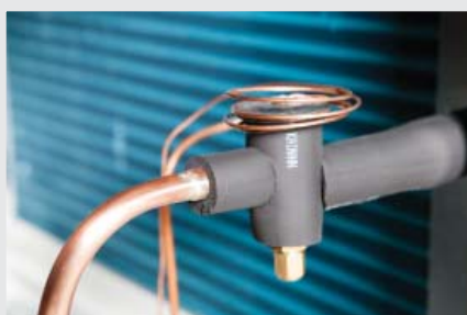
Терморегулирующий или электронный расширительный вентиль
