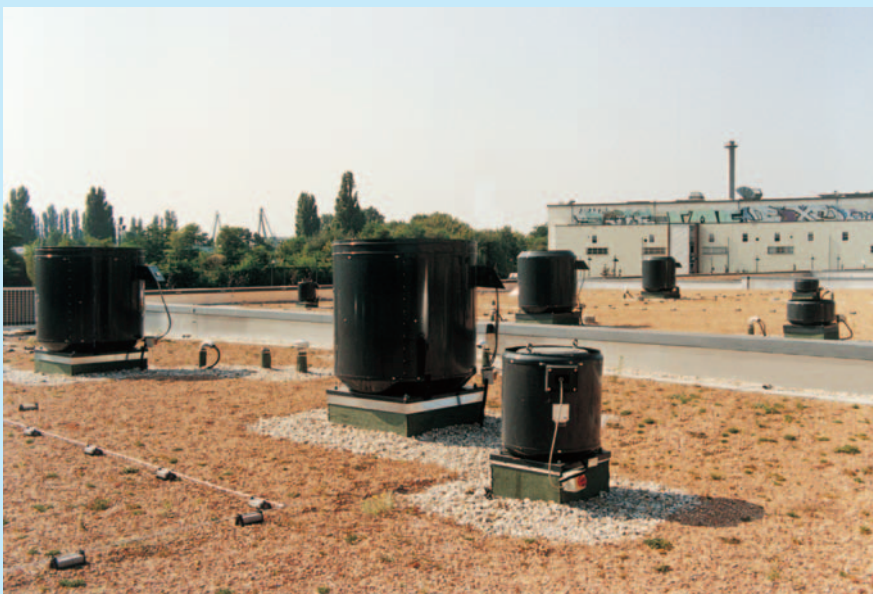
Осевые вентиляторы дымоудаления серии BVD на торговом центре в Берлин-Нойкёльн, Германия
