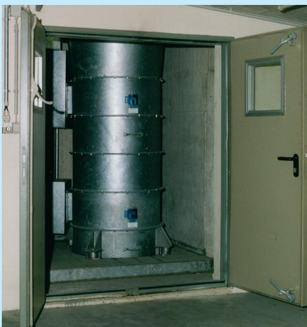
Вертикально смонтированный гаражный осевой вентилятор
