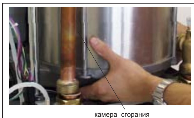
Рис: Камера сгорания
