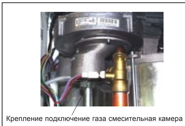
Рис.: Крепление подключение газа смесит. камера
