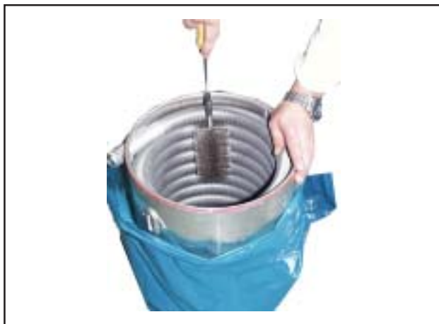
Рис.: Чистка теплообменника
