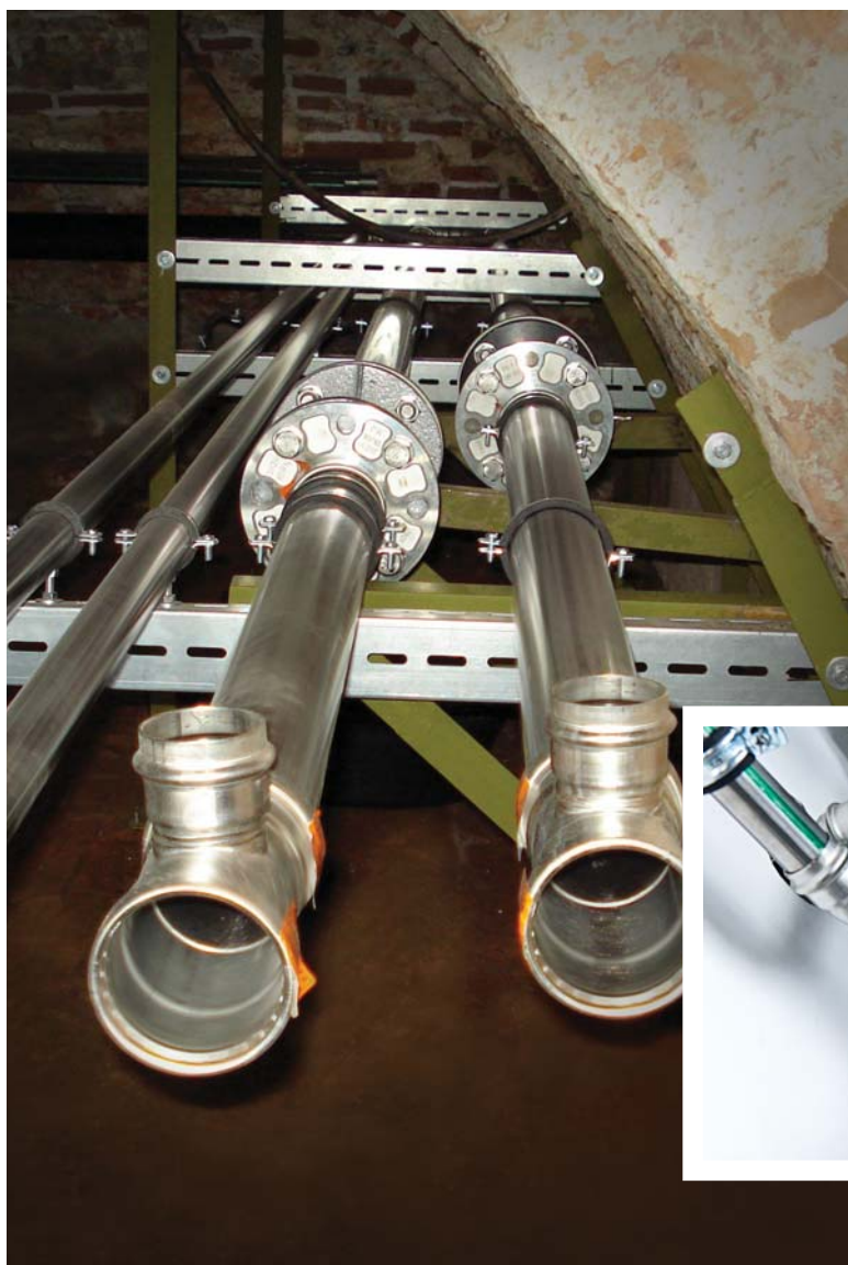
Системы кондиционирования и отопления центрального корпуса Большого Меншиковского дворца и Церковного павильона выполнены на основе Viega Sanpress Inox
