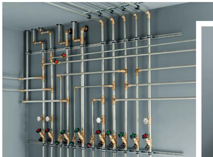
Sanpress Inox – надежная пресс-система для открытых и закрытых систем отопления, а также для питьевого водоснабжения
