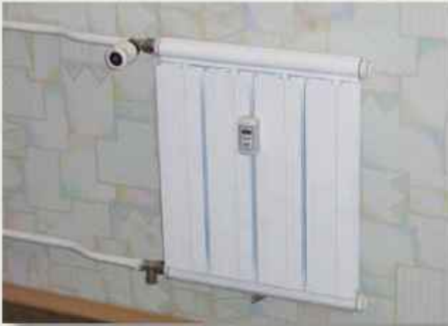
Рис. 2. Радиаторный распределитель INDIV – миниатюрная альтернатива теплосчетчику
