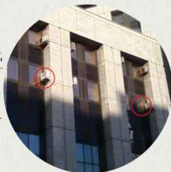
Ошибка монтажников: нижние внешние блоки смонтированы лицевой стороной к стене
