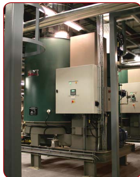
Биофармацевтическая компания Pfizer в UK. 2 x SEG-404 (2 x 6263 кг/час).
