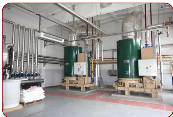
АО «Orhei-Vit» - мировой производитель соков и детского питания, Молдова. Котельная с 5 котлами Clayton SEOG-304, суммарная производительность 23,5 т/ч.
