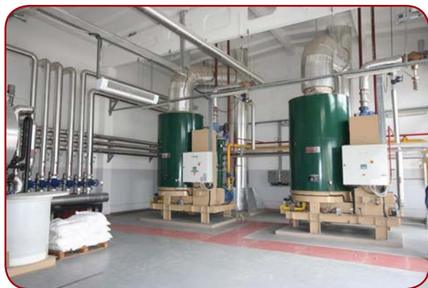
АО «Orhei-Vit» – мировой производитель соков и детского питания, Молдова. Котельная с 5-ю котлами Clayton SEOG-304, суммарная производительность 23,5 т/ч
