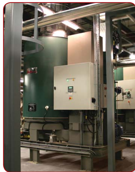
Биофармацевтическая компания Pfizer в UK. 2 x SEG-404 (2 x 6263 кг/ч)
