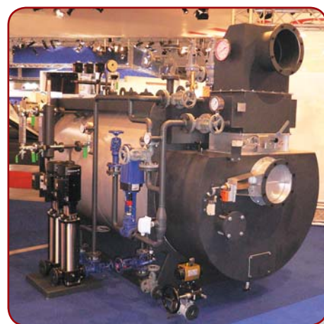
Двухходовой жаротрубный паровой котел с регулируемым экономайзером серии BHP
