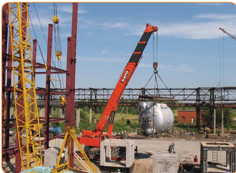
Выгрузка на стройплощадку котла производительностью 75 т/ч
