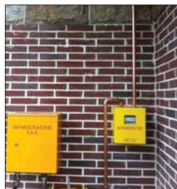
Пример монтажа газопроводной системы Viega Profipress G на объекте в России
