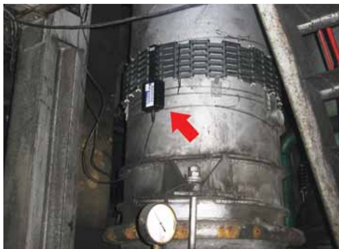
Конденсатор пара с системой Акваклер**
