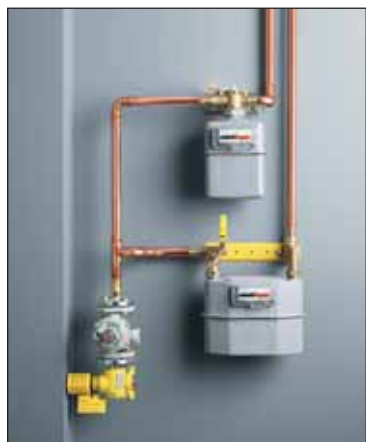
Viega Profipress G: газопроводная система для медных труб, разрешенная к применению в РФ
