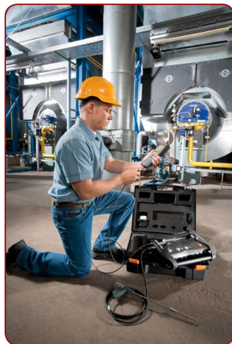
Работа на объекте с testo 350
