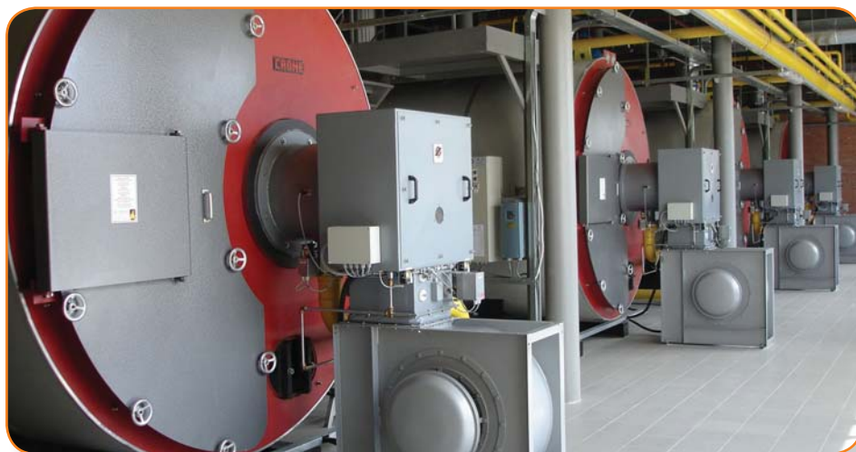
Котельные агрегаты фирмы Crone с горелками Zantingh
