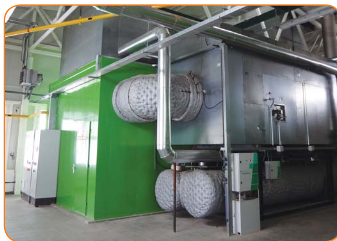
Агрофирма ООО «Круглый год». Газопоршневые установки GE Jenbacher в шумоглушащем исполнении 4 x JMS 620 с системой очистки выхлопных газов COdiNO x
