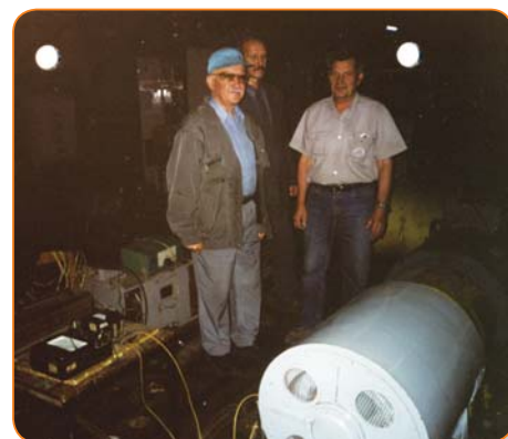
На испытаниях нового электрогенератора
