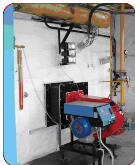
Рис. 7. Котел ДКВР 10 с одним горелочным устройством CIB UNIGAS
