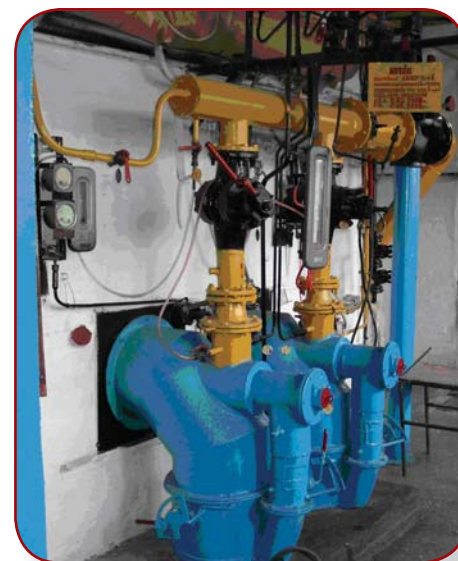
Рис. 6. Котел ДКВР 10 со штатными горелочными устройствами (2 шт.)
