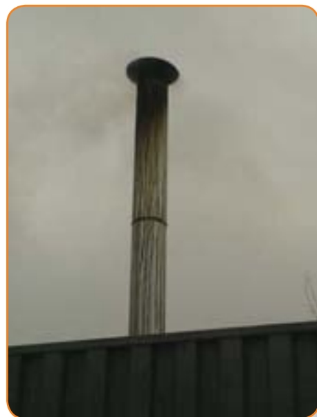
Дымовая труба, по которой течет деготь
