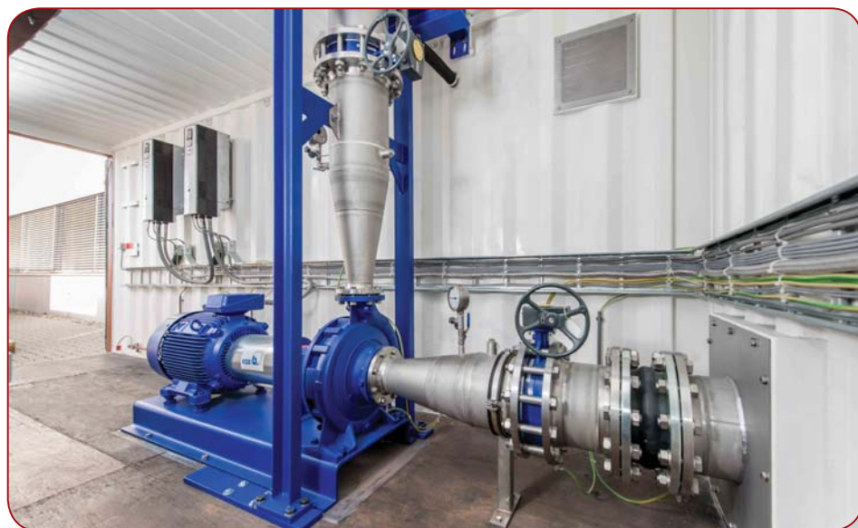
Рис. 2. Энергоблок в контейнерном исполнении с насосом в турбинном режиме
