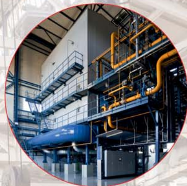
Котлы мощностью от 9,65 до 209МВт типа ПТВМ, КВ-ГМ, КВ-Р/КВ-Ф
