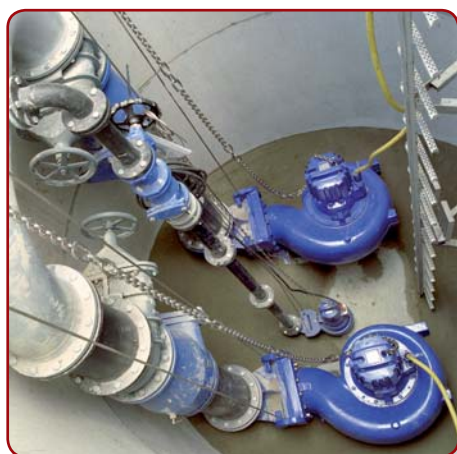
Обратный клапан в вертикальной части вертикального трубопровода
