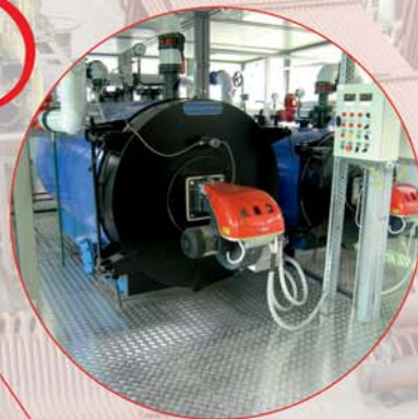
Модульные котельные МК ДКМ мощностью от 0,22 до 32МВт
