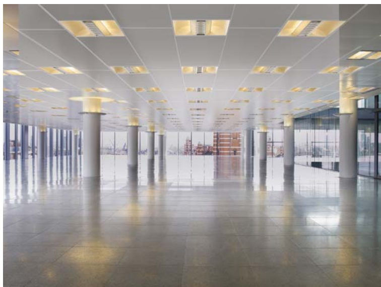
Помещение, обогреваемое потолочными панелями
