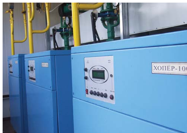
Рис. 4. Котлы «Хопер» в каскаде
