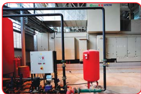
Установка поддержания давления теплосети (мини-ТЭЦ «Океанариум»)
