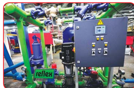
Установка поддержания давления теплосети (мини-ТЭЦ «Центральная»)
