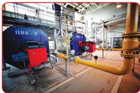
Пиковые водогрейные котлы «Термотехник» ТТ 100 мощностью по 6,5 МВт с двухтопливными горелками GKP-700 M DN80 (мини-ТЭЦ «Океанариум»)
