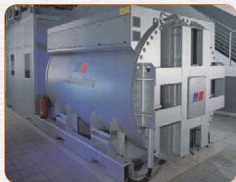
Рис. 3. Автономная система тепло- и электроснабжения на базе энергогенератора Hot Module
