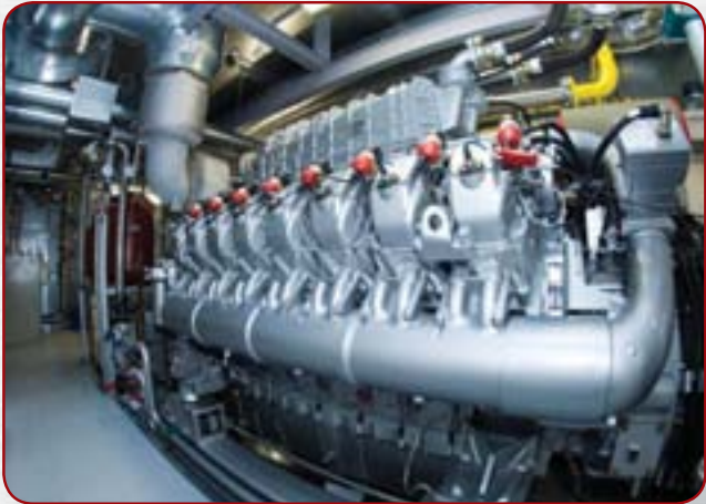
Рис. 3. Газопоршневой агрегат компании MTU Onsite Energy GmbH (Германия)
