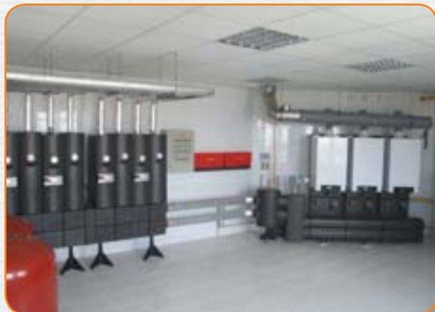
Рис. 2. Крышная каскадная котельная на базе четырех настенных котлов
