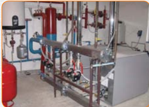
Рис. 1. Каскадная котельная с гидравлическим разделителем
