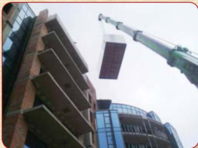
Монтаж крышной котельной с использованием автомобильного крана
