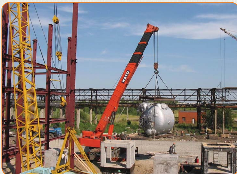
Выгрузка на стройплощадку котла производительностью 75 т/ч
