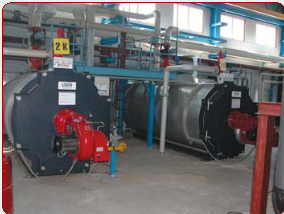
Котлы для покрытия пиковых нагрузок
