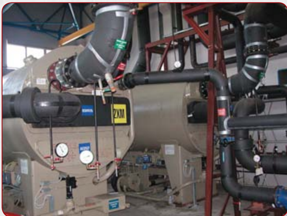
Абсорбционные машины, обеспечивающие режим тригенерации
