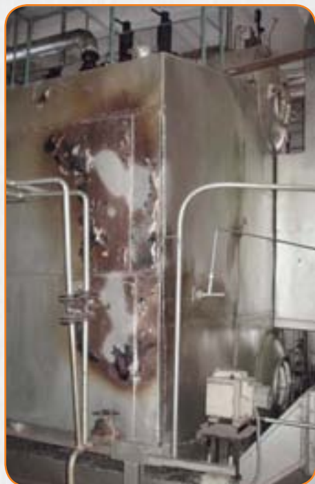
Результат применения длиннофакельной горелки на котле ДЕ-6,5
