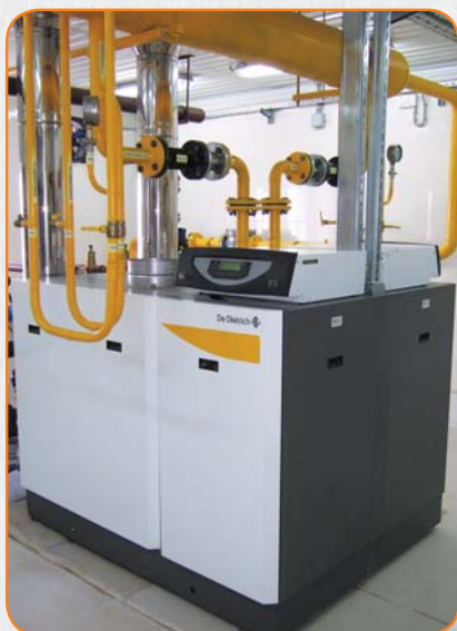
Рис. 1 Конденсационный котел С 610 в помещении котельной
