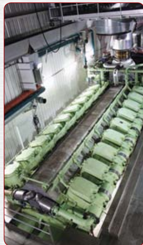
Рис. 4. Дизельный электроагрегат компании MAN Diesel & Turbo SE для работы на жидком топливе
