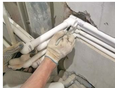
Рис. 2. Монтаж полимерного трубопровода
