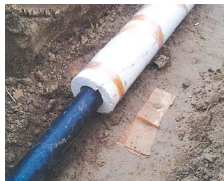
Рис. 1. Теплоизоляция подземной части полимерного трубопровода
