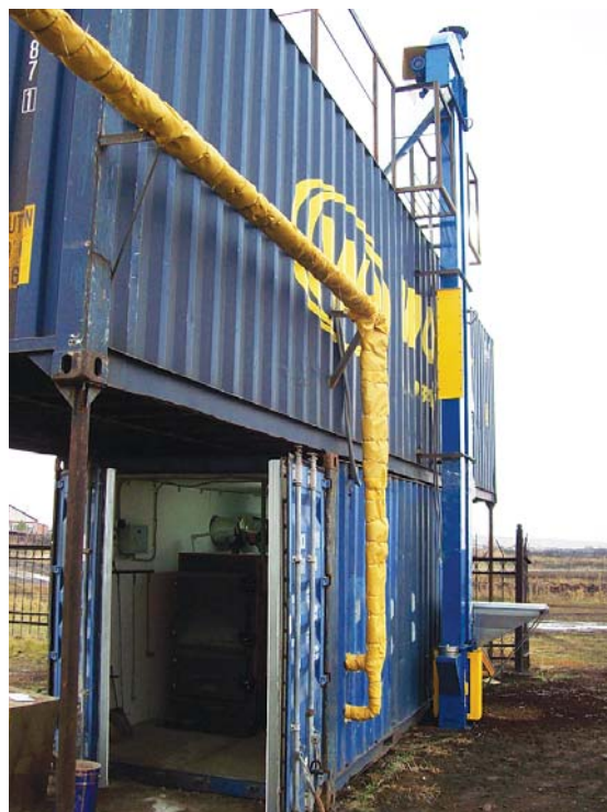
Рис. 5. Смонтированные блоки модульной котельной
