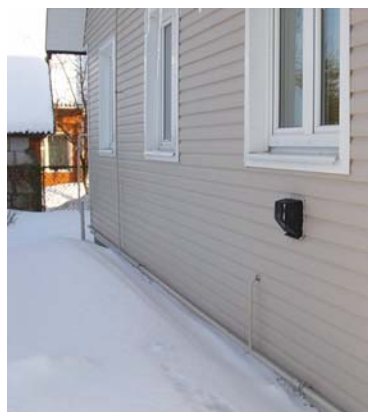
К каждому газовому конвектору газовый трубопровод подводится снаружи по фасаду дома
