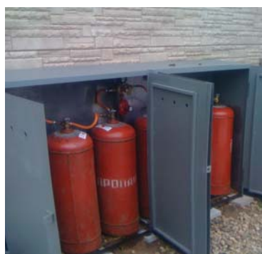
В составе групповой баллонной установки следует предусматривать запорную арматуру, регулятор давления газа, предохранительно-сбросной клапан, манометр и трубопроводы
