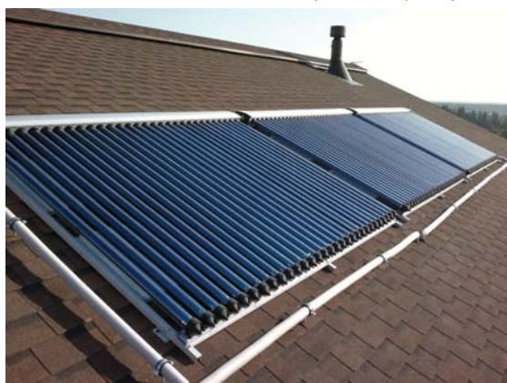
Рис. 4. Вакуумный гелиоколлектор на крыше
