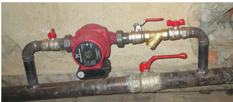
Рис. 1. Циркуляционный насос на байпасе в системе отопления
