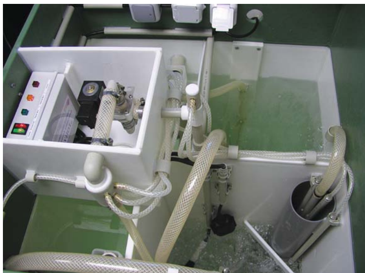
Рис. 3. Установка «Топас», работающая на основе SBR-технологии
