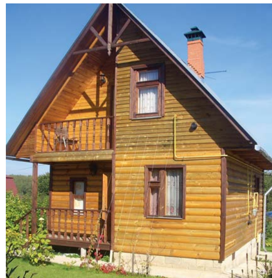
Рис. 4. Газовые трубы на фасаде здания, отапливаемого газовыми конвекторами
