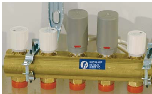
Установка приводов на обратном коллекторе
