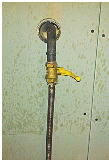
Рис. 2. Подводка газовой трубы через стену, выполненная в дополнительном футляре
