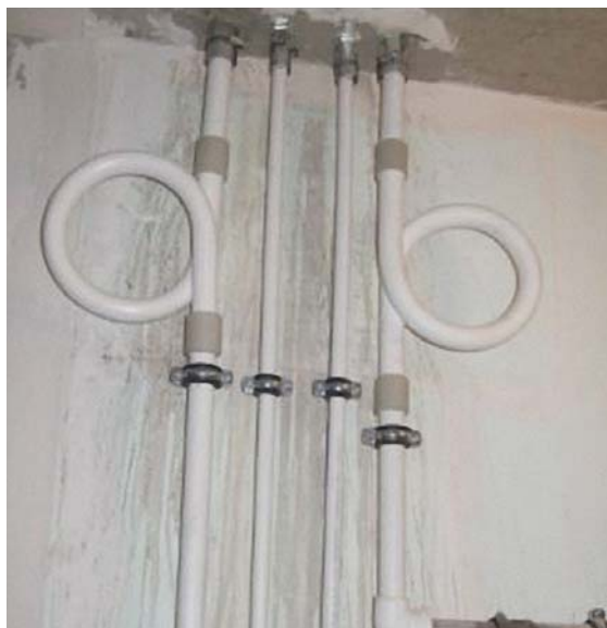
Рис. 6. Компенсатор линейного теплового расширения полипропиленовой трубы
