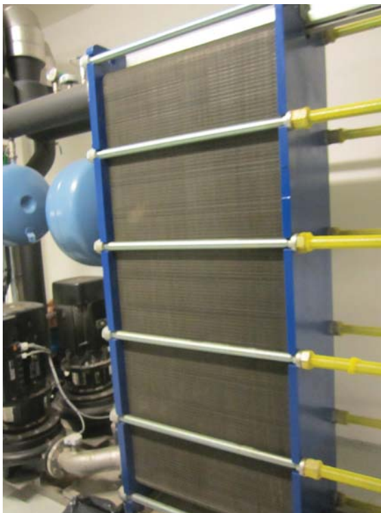
Рис. 5. Один из теплообменных аппаратов, установленных в системе кондиционирования и теплоснабжения отеля Crown Plaza
