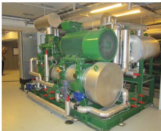
Рис. 4. Тепловой насос системы кондиционирования воздуха и теплоснабжения отеля Crown Plaza (Копенгаген, Дания)
