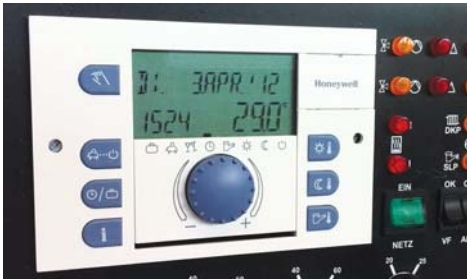
Блок многофункциональной автоматики Smile (Honeywell)
