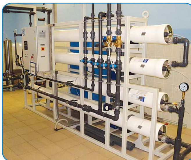
Рис. 5. Обратноосмотическая установка с 4-мя мембранными модулями
