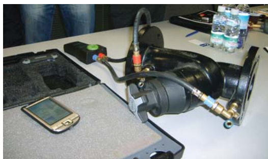
Рис. 5. Настройка балансировочного клапана
