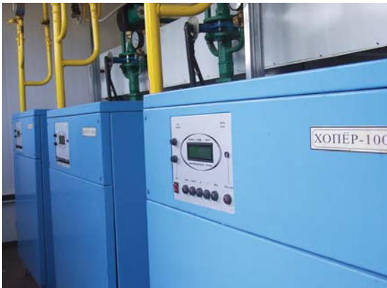
Рис. 4. Котлы «Хопер» в каскаде
