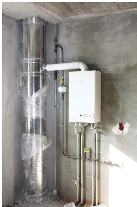
Рис. 3. Присоединение дымоотвода к коллективному дымоходу
