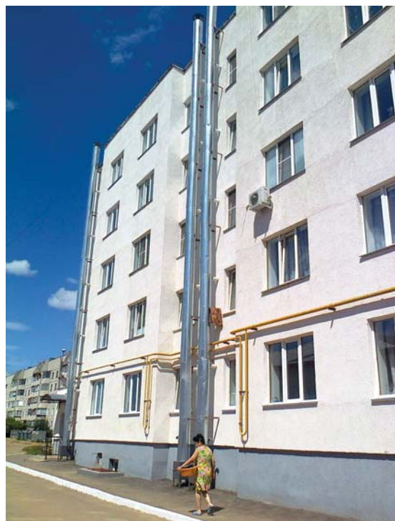
Отвод дымовых газов от котлов системы поквартирного отопления многоквартирного дома по коллективному дымоходу, расположенному на фасаде здания
