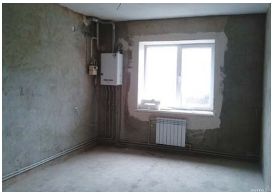
В квартире котел системы поквартирного отопления занимает совсем немного места
