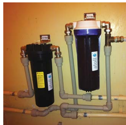
Рис. 2. Механические фильтры для осветления воды и удаления механических примесей, установленные на трубопроводах холодной и горячей воды
