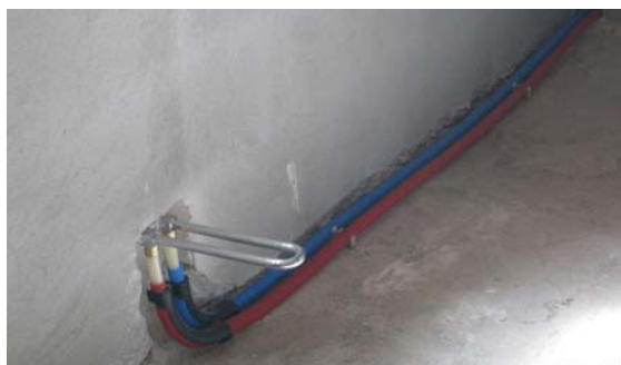
Рис. 4. При монтаже трубы из сшитого полиэтилена часто защищаются гофрированным шлангом
