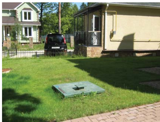
Рис. 5. Крышка ЛОС биологической очистки, расположенная на рекомендуемом расстоянии от дома
