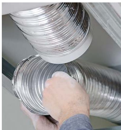
Рис. 6. Монтаж круглого воздуховода
