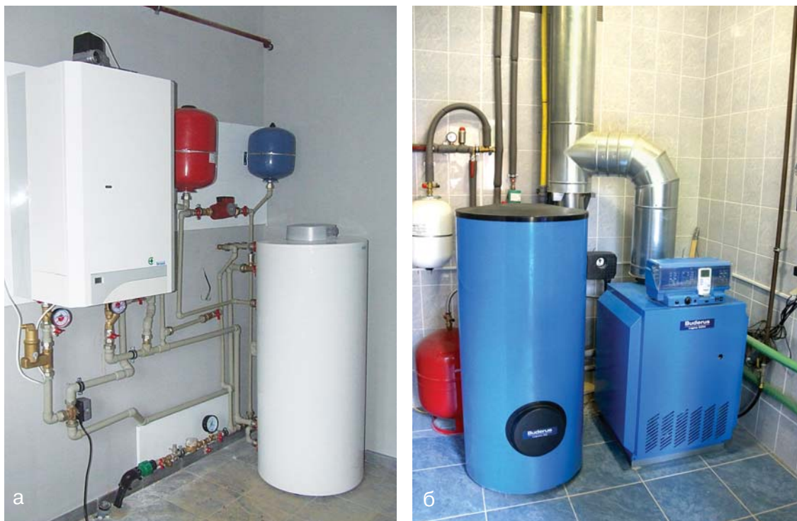
Рис. 8. Обеспечение автономного ГВС с помощью комбинации: а – настенного газового котла с бойлером косвенного нагрева; б – напольного газового котла с бойлером косвенного нагрева
