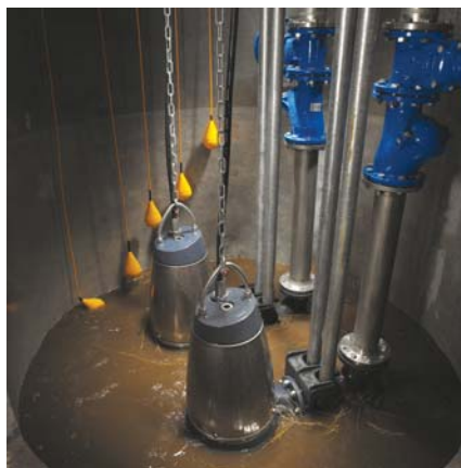
Рис. 5. Канализационная станция
