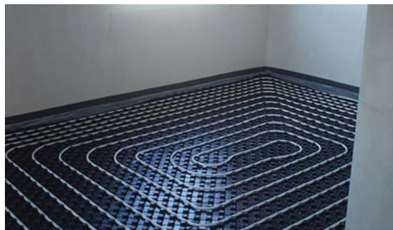
Рис. 7. Для укладки теплых полов из РЕ-Х используются маты с фиксаторами
