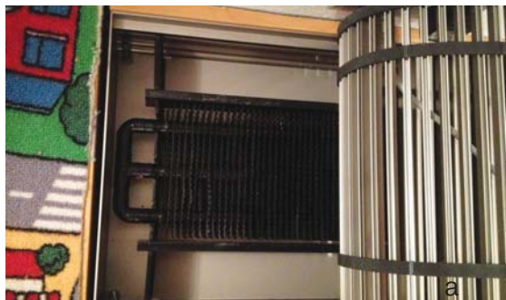
Рис. 3. Встраиваемый в пол водяной конвектор
