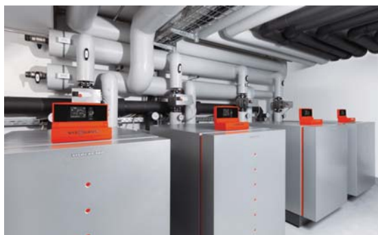
Рис. 2. Система с ТН Vitocal 300 G
