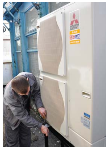
Рис. 5. Внешние блоки ТН Zubadan
