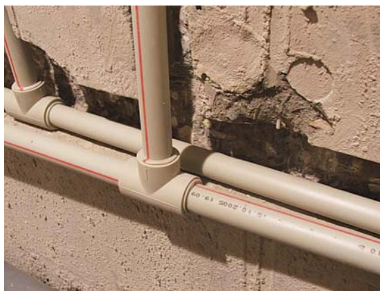
Полипропиленовые трубы в системе отопления
