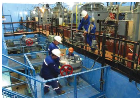
Рис. 2. Насосы на насосной станции 1-го подъема
