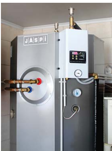
Рис. 4. Теплоаккумулятор Jaspi
