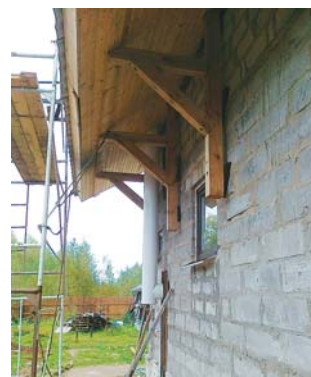
Рис. 2. Дымоотвод с конденсатосборником
