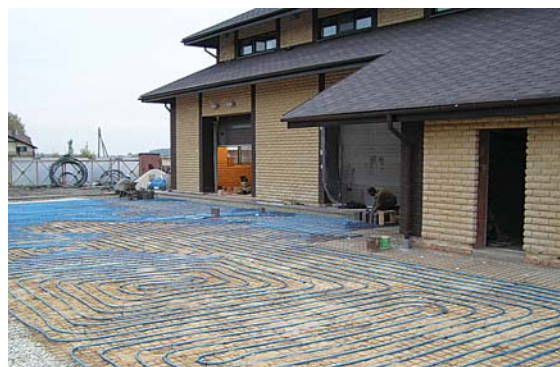
Рис. 3. Поверхность, обогреваемая системой «теплый пол»
