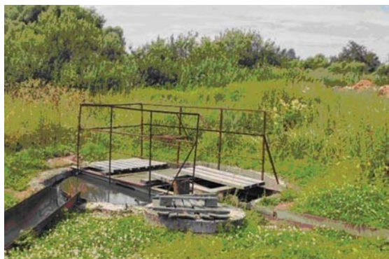
Рис. 2. Сооружения биологической очистки с прикрепленной микрофлорой на загрузке ершовой типа, используемые в качестве контактных резервуаров
