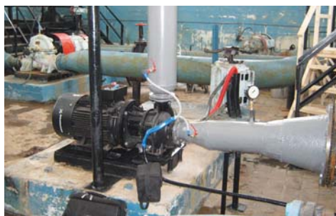
Рис. 6. Насос с частотным преобразователем двигателя, установленный на объекте ООО «Водоканал» г. Соликамска
