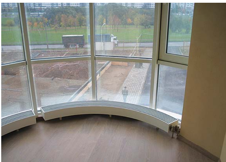
Рис. 1. Конвектор «Элегант-мини»
