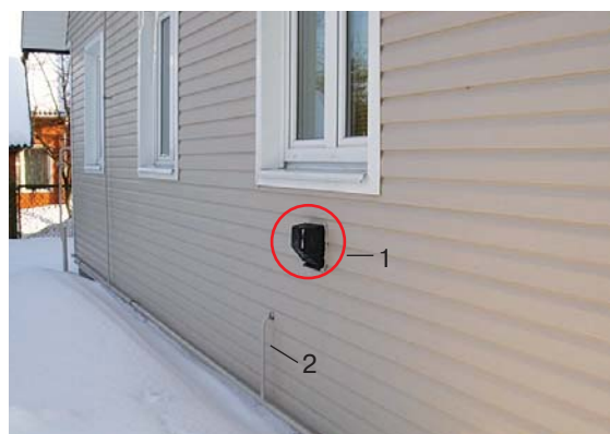
Рис. 6. Оголовок коаксиального газохода на внешней стене здания (1) и подвода газа (2) к конвектору через стену
