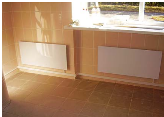
Рис. 1. Электрические конвекторы в составе системы прямого электрического отопления
