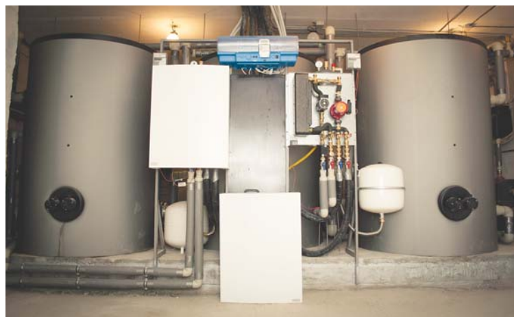
Рис. 3. Буферная емкость и насосная станция установки аккумуляции солнечной энергии
