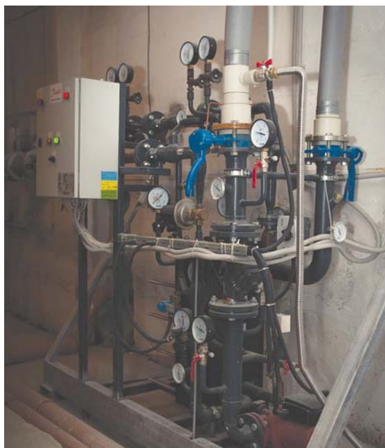
Рис. 2. Блочный тепловой пункт закрытой системы отопления, установленный в энергоэффективном доме
