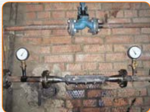
Рис. 3. Общий вид устройства приготовления водонефтяной эмульсии для сжигания в топке котла
