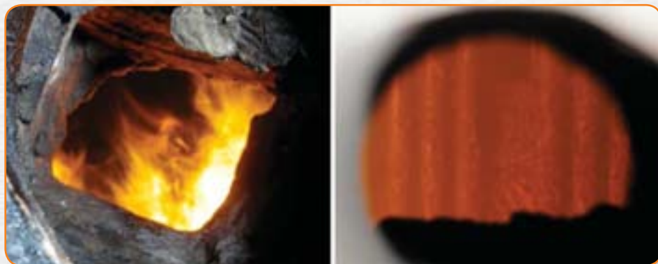
Рис. 4. Общий вид факельного сжигания нефти в топке котла ДКВР-10/13:
