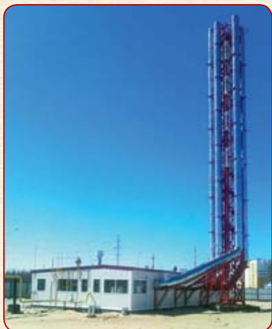
Водогрейная котельная мощностью 30 МВт и дымовая труба высотой 30 м (г. Нижневартовск)
