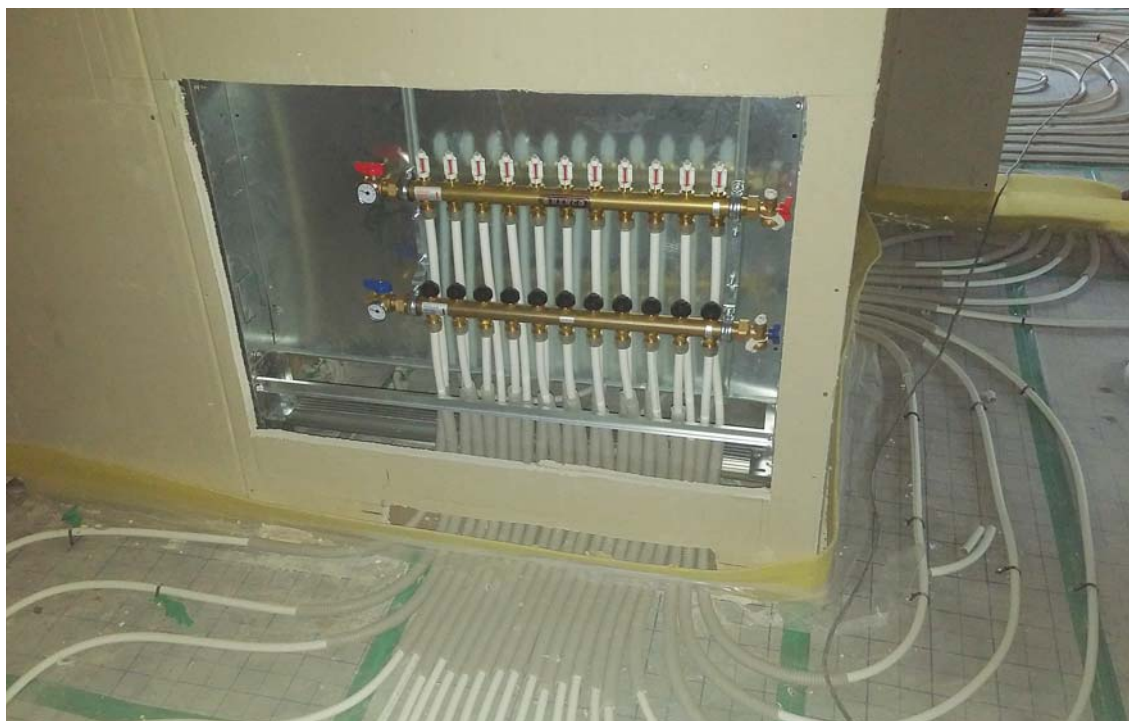
Рис. 2. Подключение труб теплого пола к коллекторному шкафу
