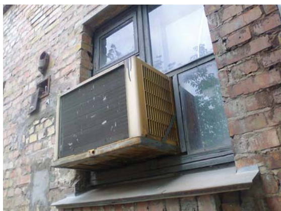
Рис. 1. Оконный кондиционер БК
