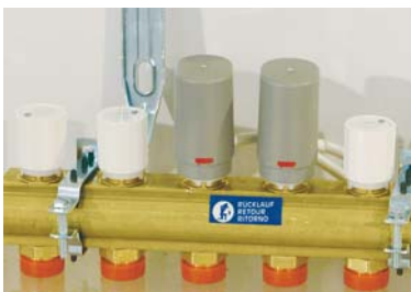
Установка приводов на обратном коллекторе
