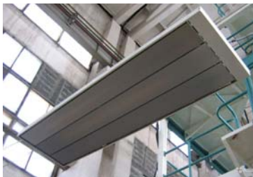
Рис. 5. Потолочный обогреватель «Купол ОИм-2.0»
