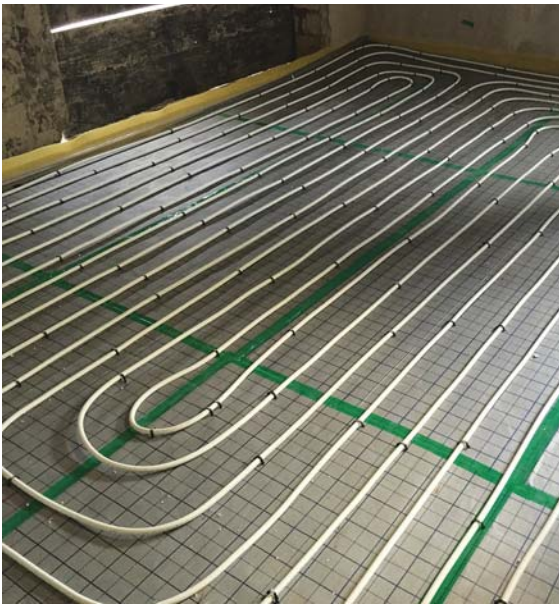
Рис. 3. Монтаж МП труб HENCO на матах UFH-TACK с помощью крепежных скоб UFH-TACK-40
