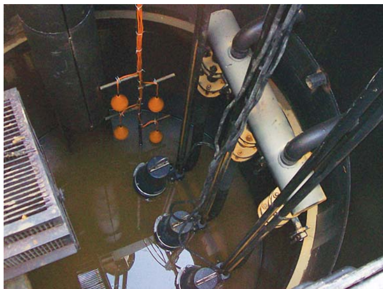
Рис. 3. Внутренность емкости насосной станции с насосными агрегатами и поплавковыми датчиками уровня перекачиваемой среды
