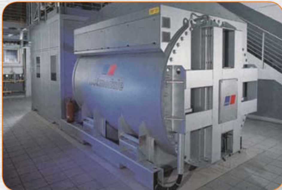
Рис. 3. Автономная система тепло- и электроснабжения на базе энергогенератора Hot Module
