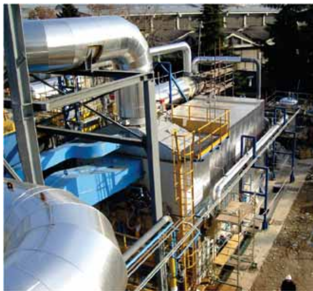
Установка для производства перегретой воды СТН-40 МВт-для ТЦ Бергамо - Италия
