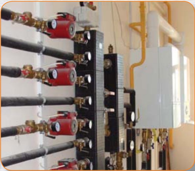
Подающие и обратные линии котлов каскада
