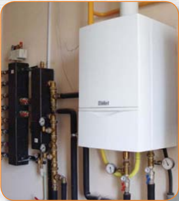
Работа одного котла каскада
