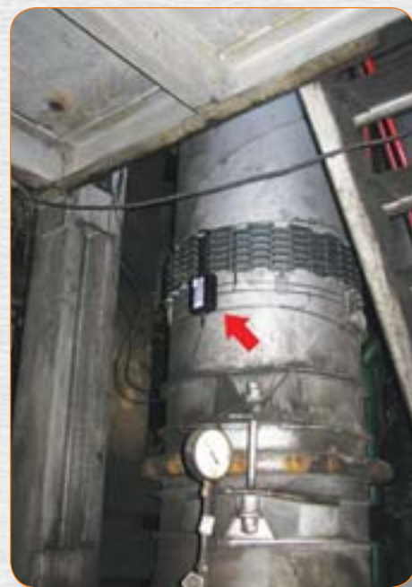
Рис. 6. Установка Акваклёр монтируется без остановки системы охлаждения
