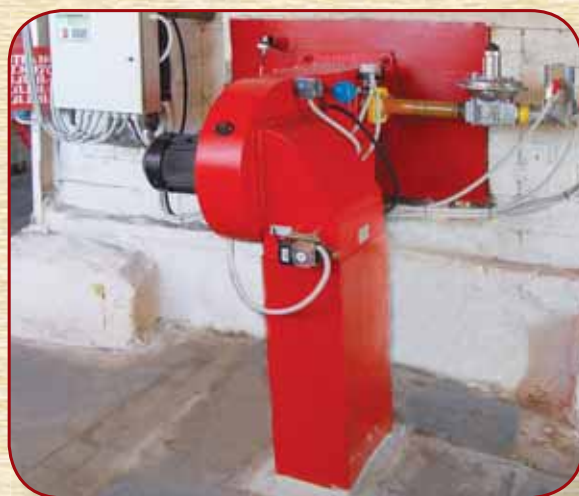
Короткофакельная газовая горелка ГБЛ-2,8 на котле ДКВр-4,0-13
