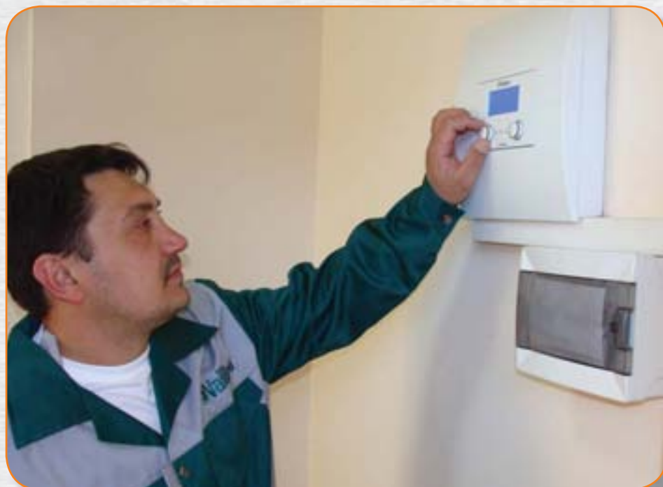
Контроллер Vaillant colorMATIC
