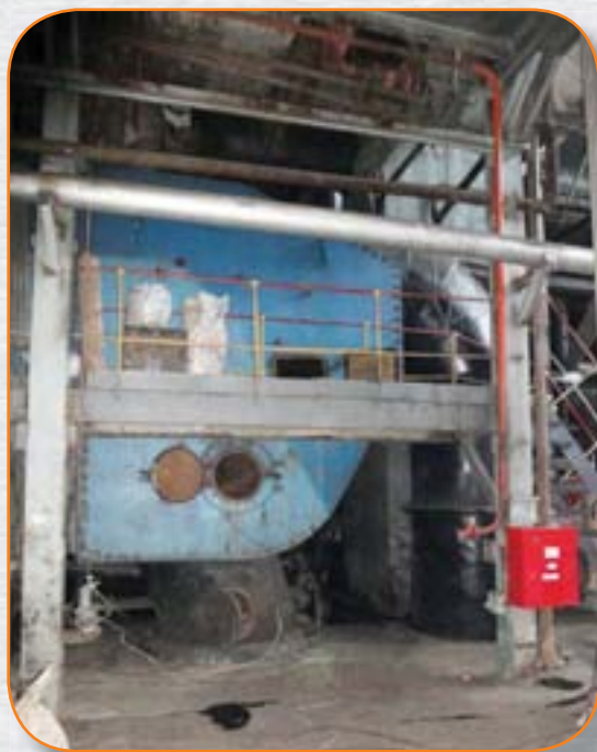
Рис. 1. Один из конденсаторов пара энергоблока № 2 Назаровской ГРЭС во время проведения механической очистки
