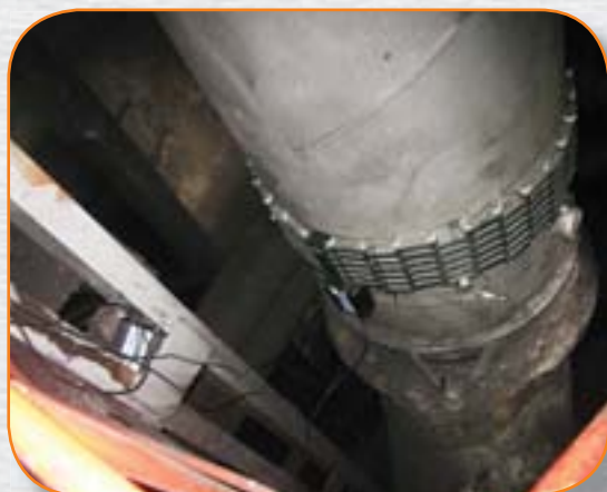
Рис. 2. Флокулирующее устройство Акваклёр смонтировано на циркуляционный водовод конденсатора пара (Барнаульская ТЭЦ 3)
