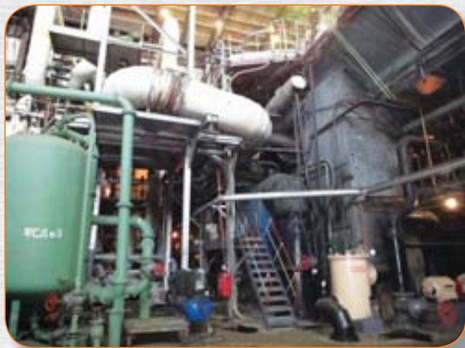
Рис. 4. Вид на энергоблок № 2 Назаровской ГРЭС. Видны конденсатор пара (синий) и один из циркуляционных водоводов (черный трубопровод большого диаметра на переднем плане)
