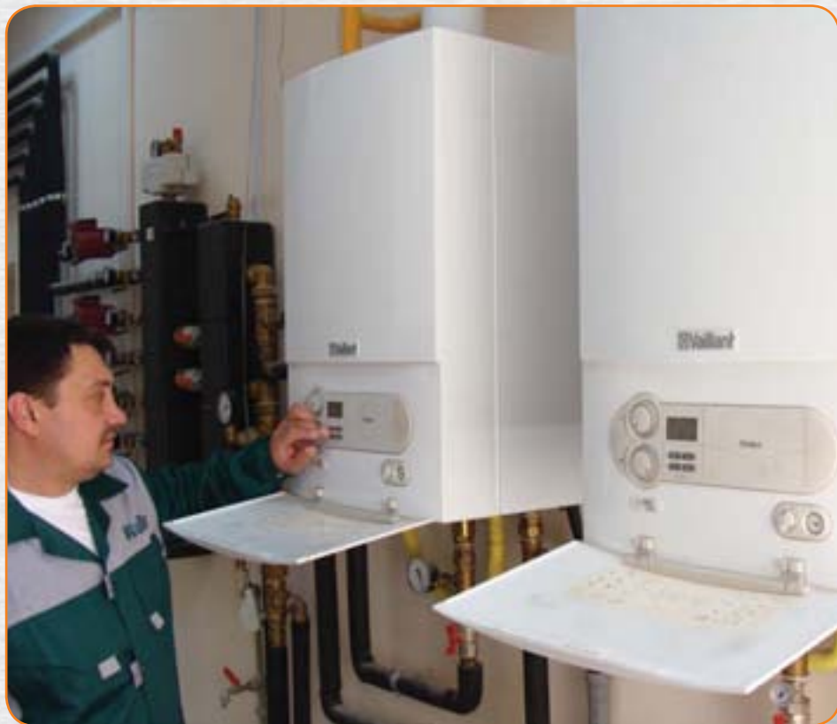
Настенные конденсационные котлы Vaillant Eco TEC plus VU 466 производства Vaillant Group с модулирующими горелками
