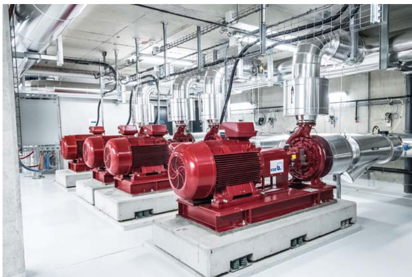
Рис. 2. Насосы MegaCPK контура теплоснабжения
