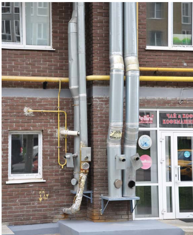
Фото 1. Город Чебоксары, разрушающийся дымоход в многоквартирном жилом доме после 5 лет эксплуатации
