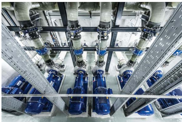
Рис. 1. Насосы MegaCPK для подачи морской воды
