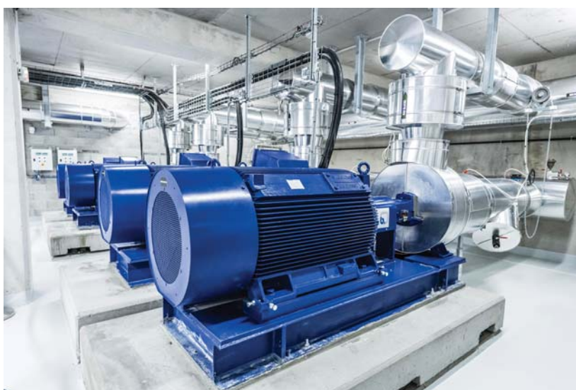
Рис. 3. Насосы MegaCPK контура холодоснабжения
