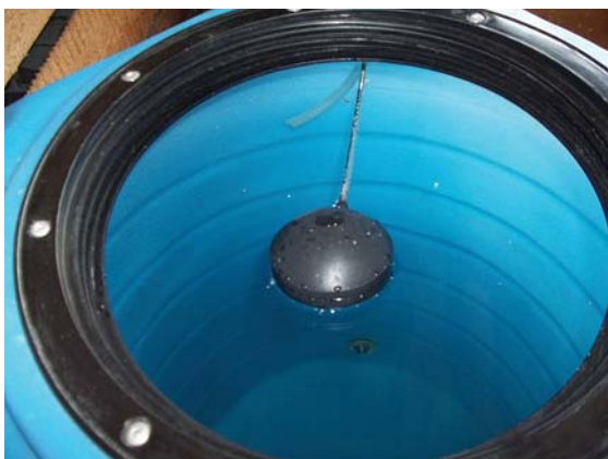
Рис. 4. Поплавковый кран на входе в накопительный бак
