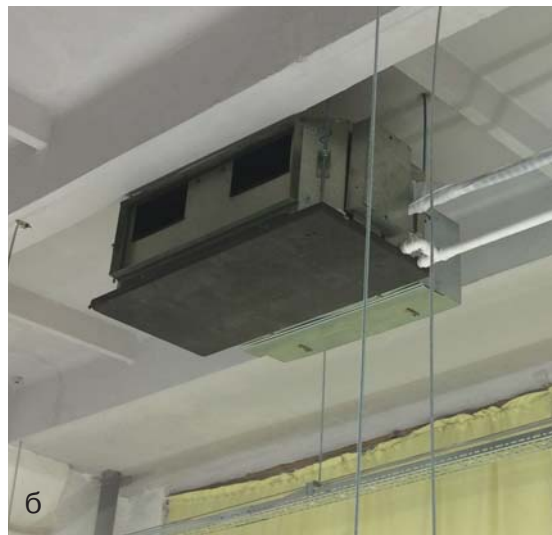
Рис. 2. Канальный кондиционер: а – типы внутренних блоков канального кондиционера; б – монтаж канального кондиционера компании Fujitsu
