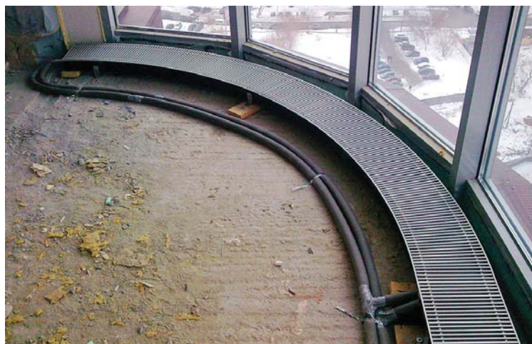
Рис. 2. Монтаж впольного конвектора при панорамном архитектурном решении
