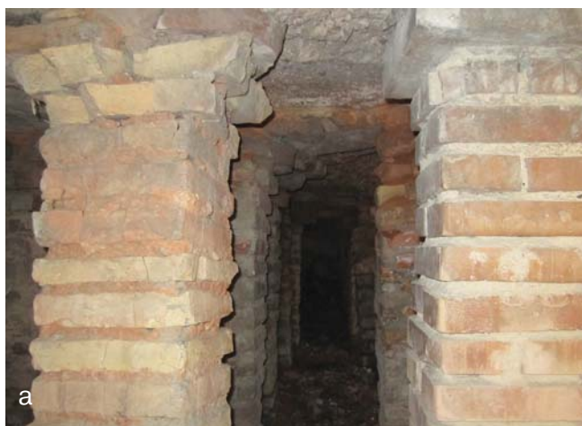
Рис. 1. Теплый воздух поступал в подпольное пространство римских терм (а), а оттуда, прогревая пол (б), и в банное помещение (остатки пола и подпольного пространства в римских термах, г. Арль, Франция)
