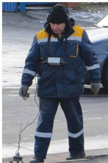
Рис. 2 Локализация места утечки на теплотрассе с помощью акустико-теплометрического течеискателя
