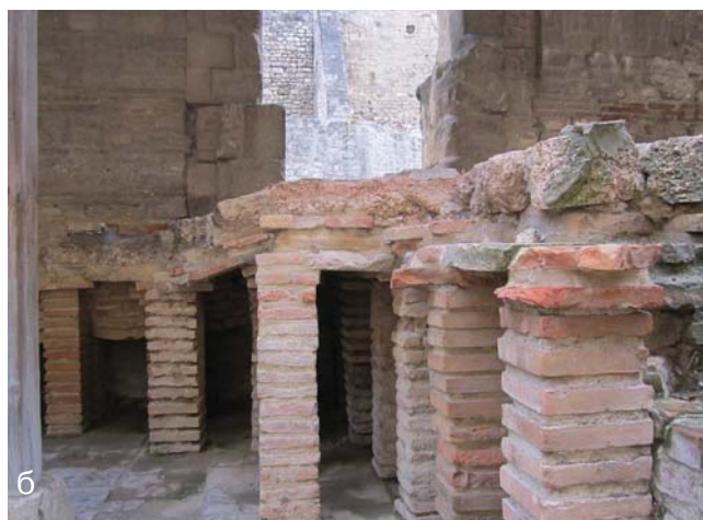
Рис. 1. Теплый воздух поступал в подпольное пространство римских терм (а), а оттуда, прогревая пол (б), и в банное помещение (остатки пола и подпольного пространства в римских термах, г. Арль, Франция)
