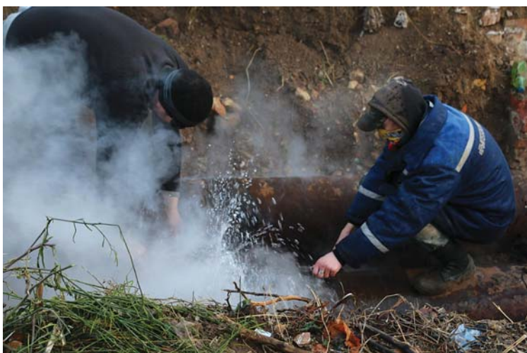
Рис. 1. Ремонтные работы на теплотрассе
