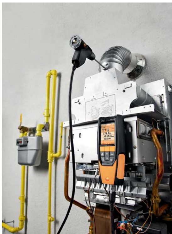
Рис. 4 Настройка работы газового котла с помощью газового анализатора
