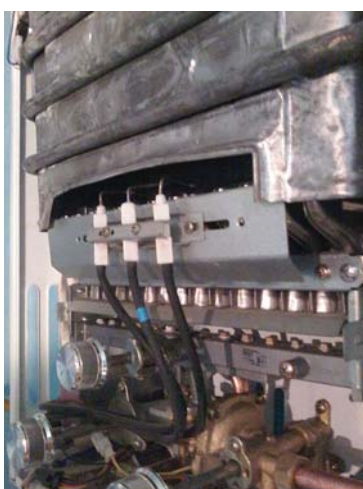
Рис. 3. Запальные и контрольные электроды, установленные на газовой колонке
