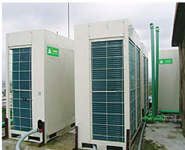
Рис. 4. Наружный блок VRF-системы
