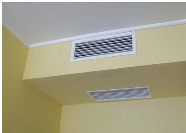
Рис. 1. Квартирный каналный кондиционер
