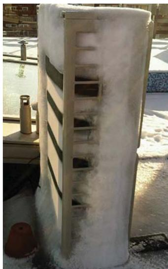
Рис. 3. Обмерзание наружного блока
