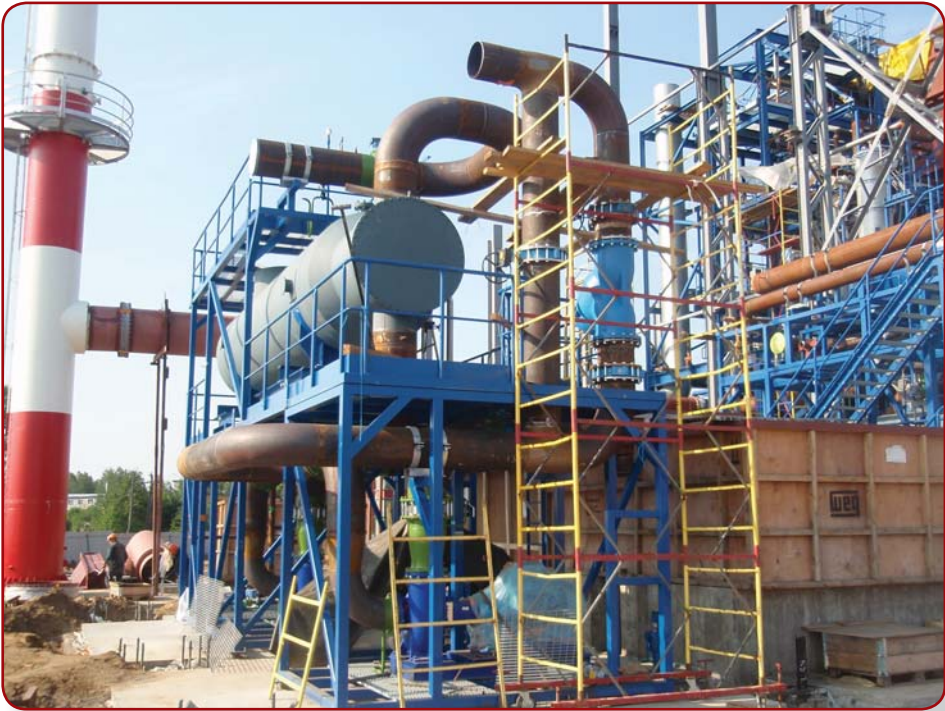
Рис. 2. Монтаж модуля теплообменника горячей воды
